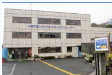
▲ 橋リサイクルコミュニティセンター
