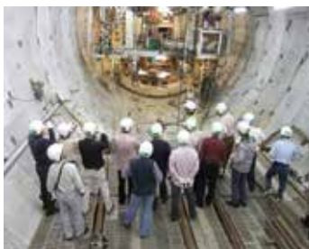
五反田川シールドトンネル内
