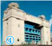
④ 川崎河港水門
