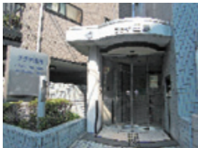
プラザ田島正面玄関
