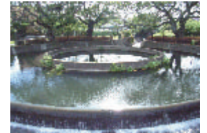
1941年平賀栄治の設計で作られた久地円筒分水
