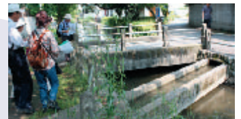
立体交差させて水を供給している
