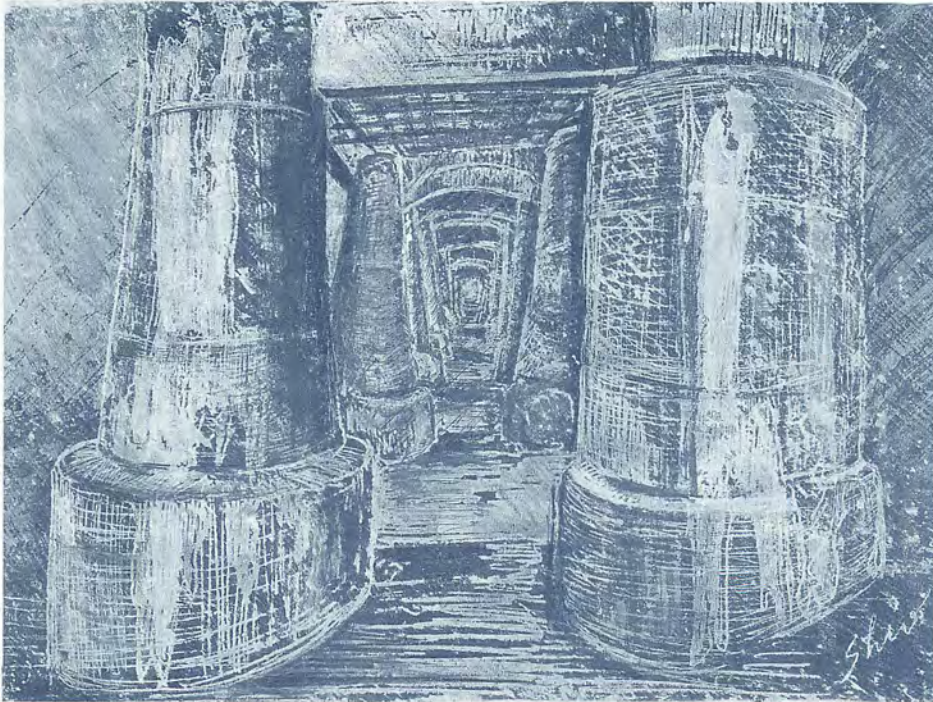
二子橋の橋脚
