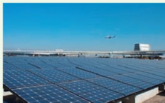
浮島太陽光発電所の上を飛行する飛行機
