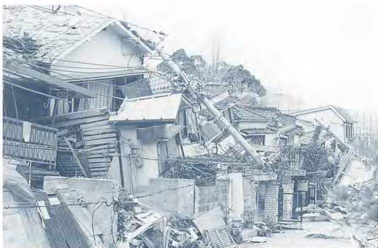
阪神大震災で倒壊した神戸の民家(市防災対策室提供)
